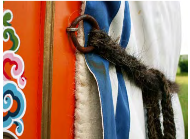
Abbildung 8: Übergang von Türrahmen, Filz und Aussentuch, Seil aus Tierhaaren
