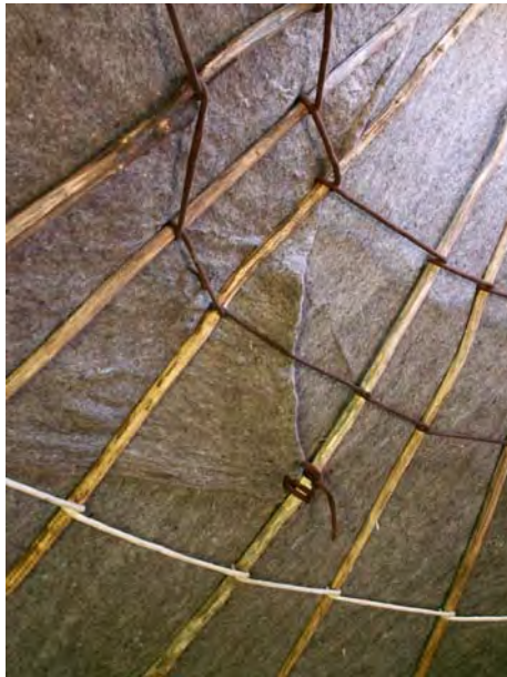
Abbildung 6: Jurtendach von innen; Fixierung der Dachstangen mit Filzseilen
