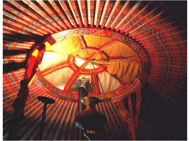
Abbildung 1: abgedeckte Krone mit beiden Dachstützen
