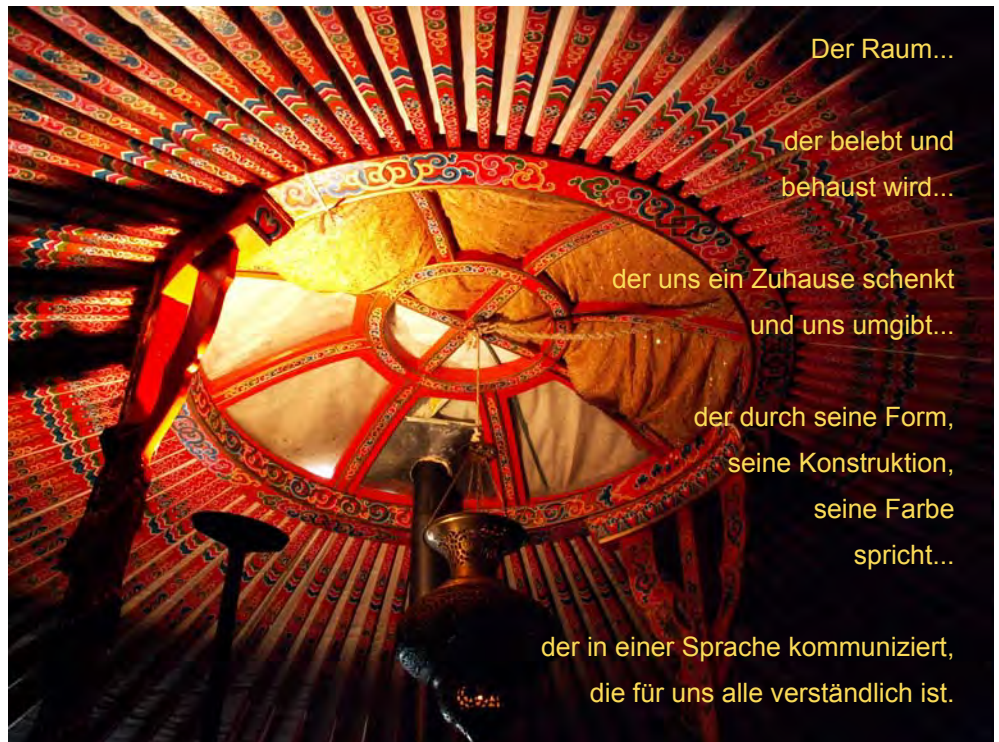
Abbildung 1: Krone und Dachstangen des gers ( mongolische Jurte) von Irène Moser, vgl. Anhang C
