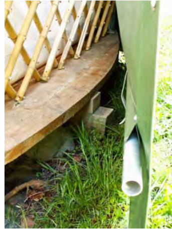
Abbildung 8: Übergang Scherengitter, Boden, Aussenplastik
