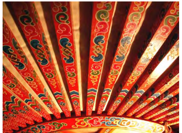
Abbildung 4: oberster Abschnitt der Dachstangen - oben viereckig in Ring, unten rund
