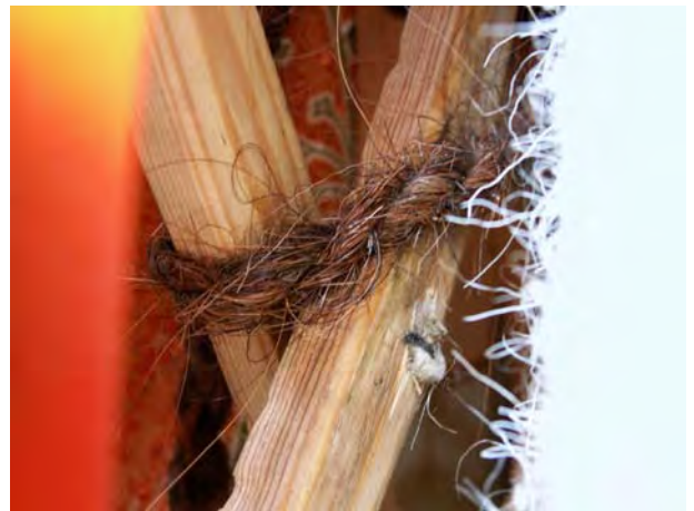
Abbildung 10: Scherengitterkreuzpunkt
