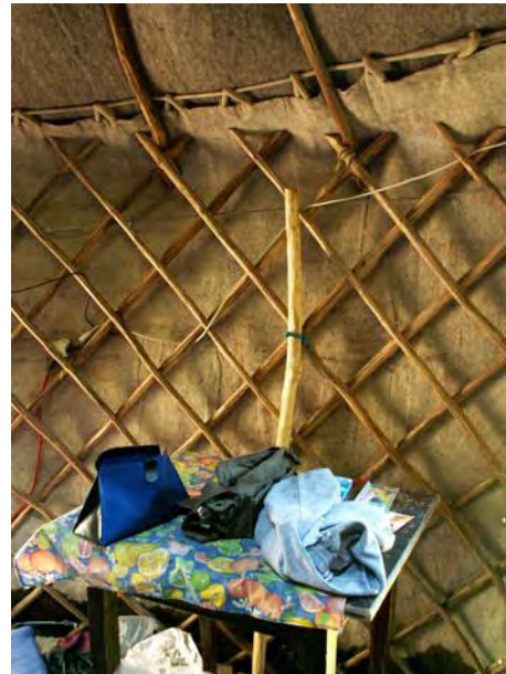
Abbildung 7: der Verankerung dienender Holzpfosten; Hasel-Scherengitter und Aufhängevorrichtung des Wandfilzes
