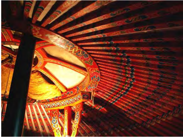
Abbildung 2: Krone mit einer Stütze und Kamin
