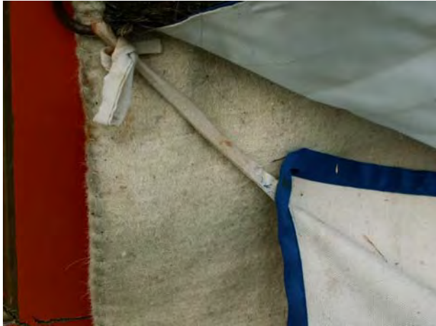
Abbildung 7: Übergang zwischen Wandtuch und Bodenschutzstreifen - Situation am untersten Ring
