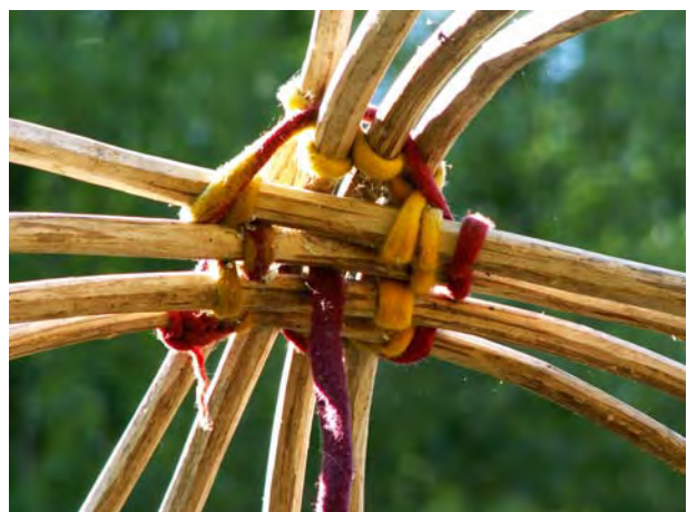
Abbildung 3: Haselruten in der Dachöffnung mit Filzchnüren verbunden
