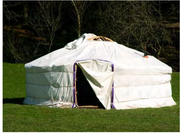
Abbildung 4: "Urchi"- Jurte, mit Haselruten gebaut, gebunden, Huttwil '05
