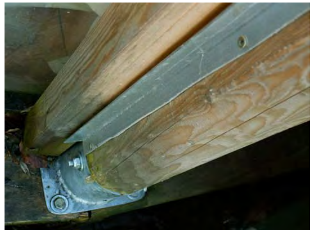
Abbildung 4: Wandpfostenverankerung im Boden
