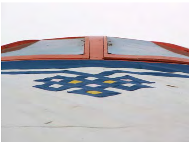
Abbildung 5: Plexiglas - Dachfenster mit Verzierung des Aussentuches; der buddhistische Glücksknoten ist oft an Jurten angebracht
