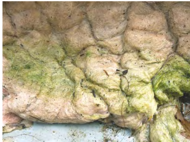
Abbildung 6: Staunässe beim Übergang von Filz zu Bodenkonstruktion; mit Algen oder Pilzen versetzter Filz
